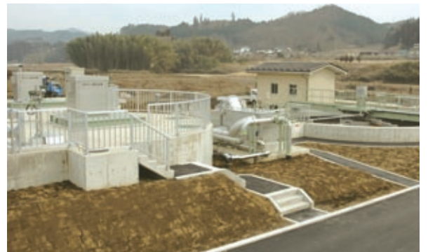
下水処理施設(馬頭浄化センター)
