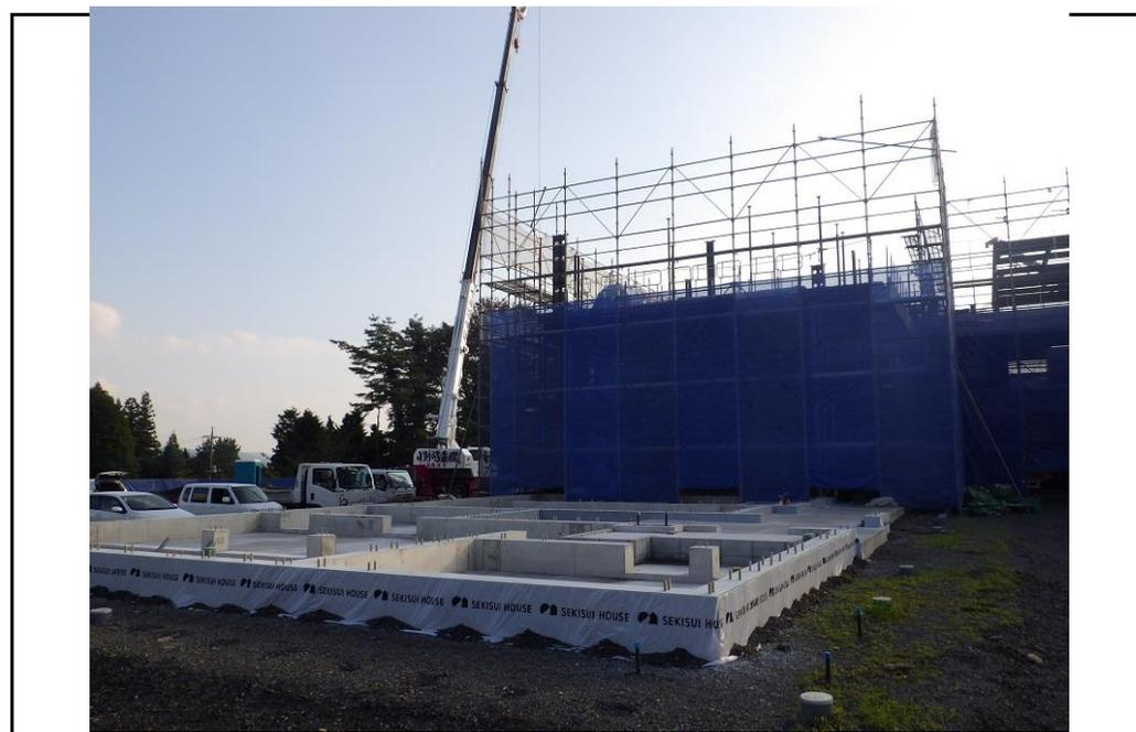
住宅南側 : 1・2階部分は外壁が施工され、3階部分の躯体工事が行われています
