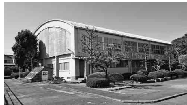
小川小学校体育館の改修工事を実施
