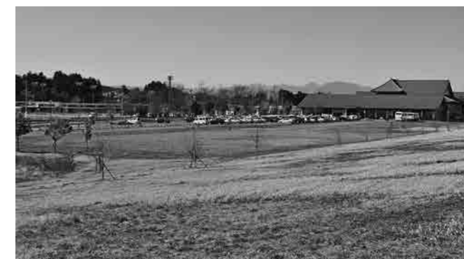
防災型太陽光発電システムを整備します
