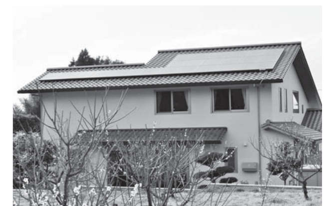
太陽光発電施設
