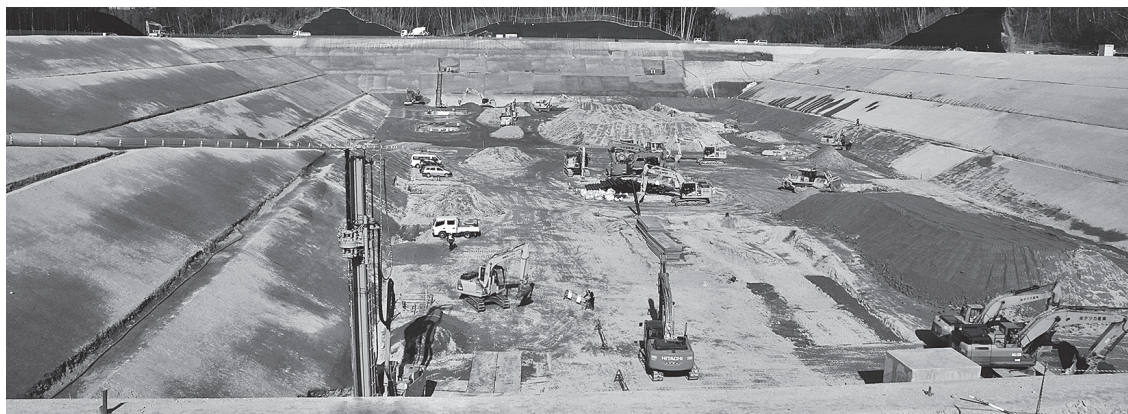
工事が進む現場
