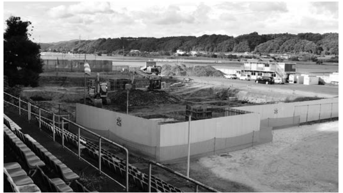
建設が進む町民プール
