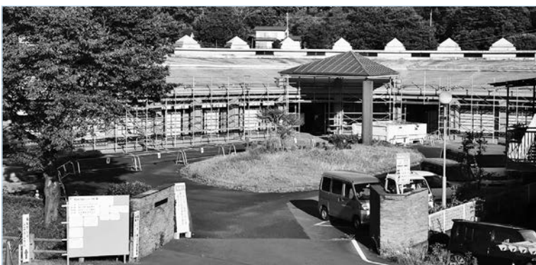
馬頭総合福祉センター改修工事の様子
