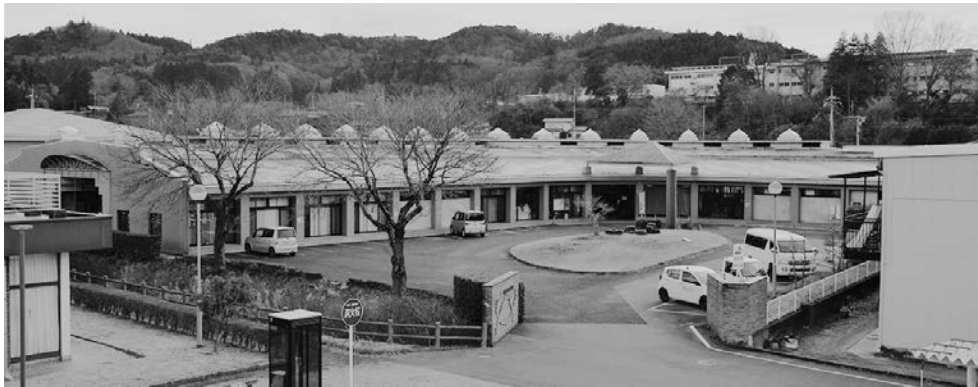
改修工事が行われる馬頭総合福祉センター
