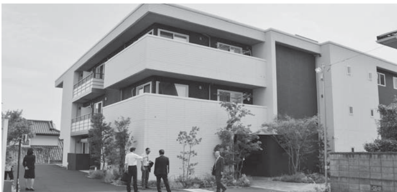
積水ハウスグループが運営する、常陸太田市の定住促進住宅「ファミリーくじらヶ丘」
